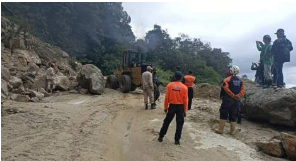
Remoción de sedimentos producto de movimiento de masa en vialidad del sector La Cumbre del Parque Nacional Henri Pittier, en fecha 09, 10 y 11/10/2022. Fuente: INPARQUES
